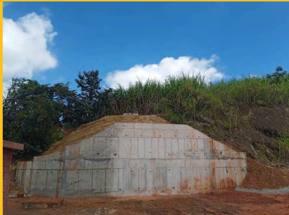
SERVICOS DE CONSTRUÇÃO DE MURO DE ARRIMO - OURO BRANCO / MG
