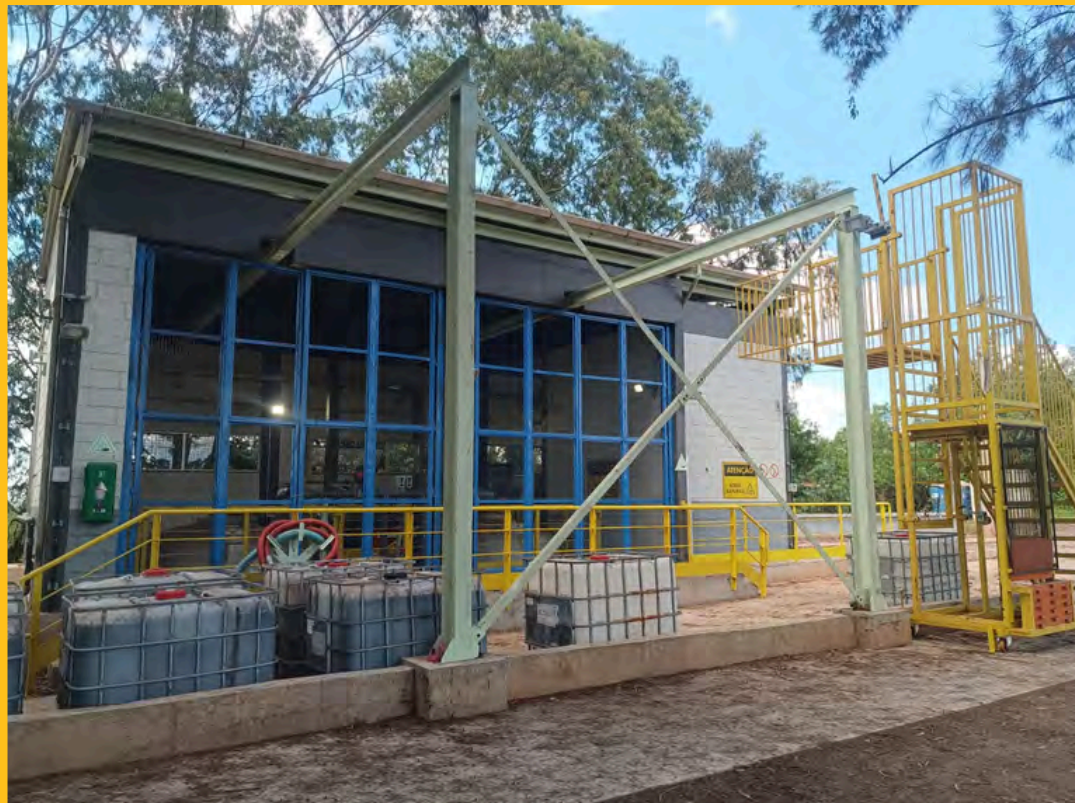
VISTA EXTERNA DA CASA DE QUÍMICA, OBRAS CIVIS, MONTAGEM DE MONOVIA, ESCADA PLATAFORMA E RAMPA E DIQUE DE CONTENÇÃO - OURO BRANCO - MG
