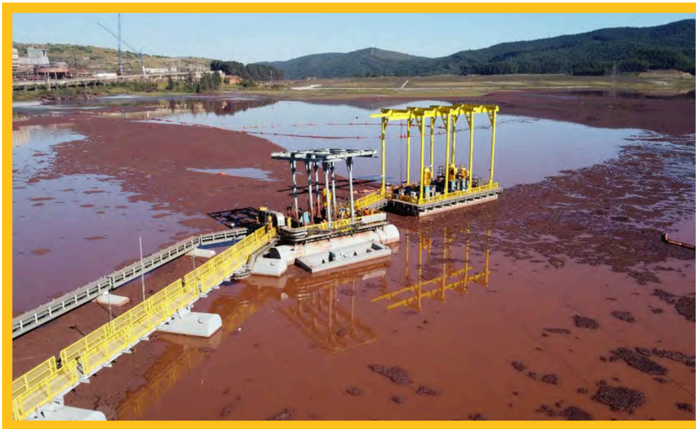
ADEQUAÇÃO DE BALSAS DA BARRAGEM DE CONCEIÇÃO - ITABIRA/MG
