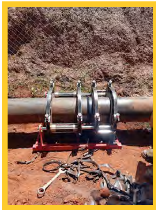
TRANSIÇÃO DE SOLDA DE TUBULAÇÃO DE AÇO CARBONO PARA PEAD - SUMP 3 - MINA DE CAUÊ - ITABIRA/MG
