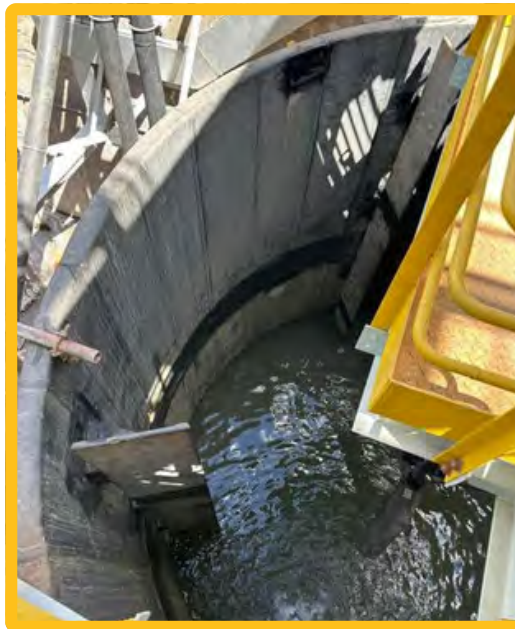
MONTAGEM DAS TRAVAS DAS TAMPAS DOS LEITOS DE 400MM, REVESTIMENTO DO TANQUE TQ-091 E ADEQUAÇÃO DE ESCADA DE ACESSO A BASE DO TQ-091
