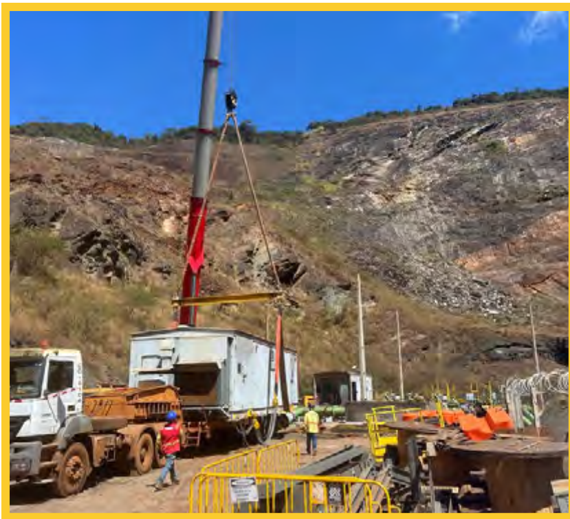
DESMONTAGEM DE ELETROCENTRO E TROCA DE LONGARINAS DA RETOMADORA EM TIMBOPEBA/MG
