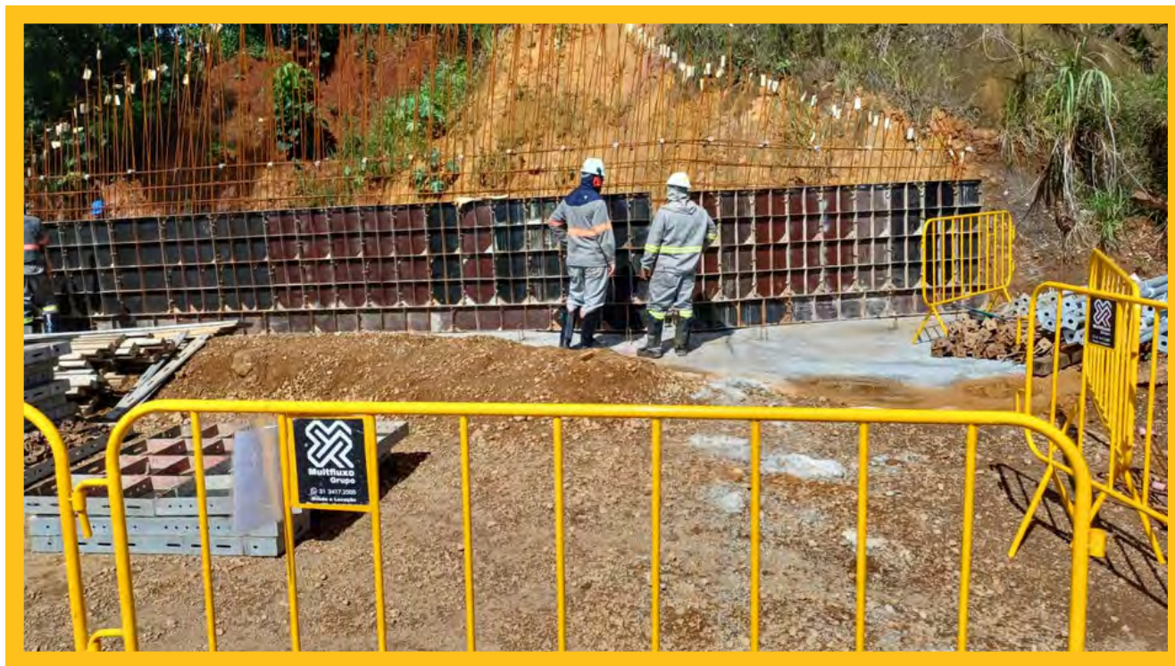
SERVICOS DE CONSTRUÇÃO DE MURO DE ARRIMO - OURO BRANCO / MG
