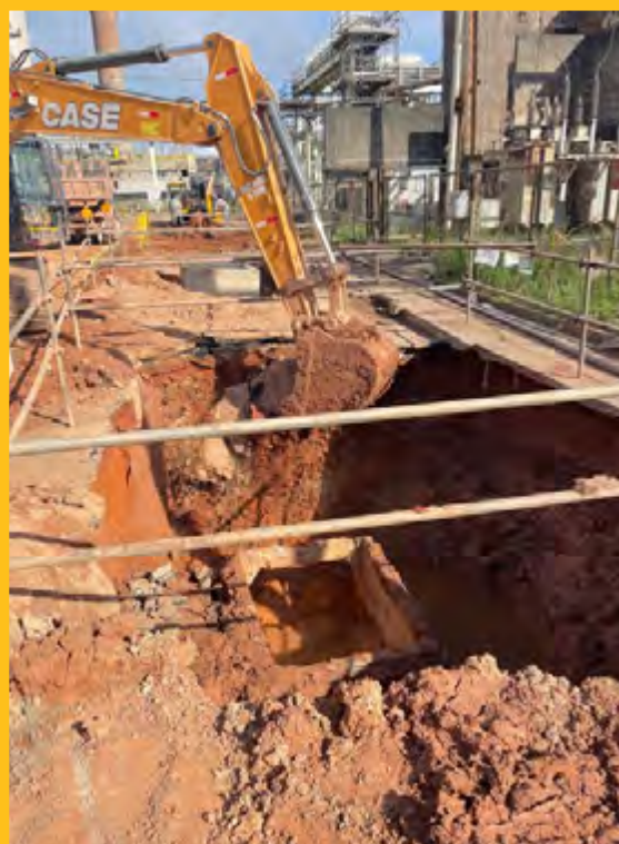
SERVIÇO DE ESCAVAÇÃO PARA DRENAGEM DA REDE PLUVIAL NA ACIARIA - OURO BRANCO/MG
