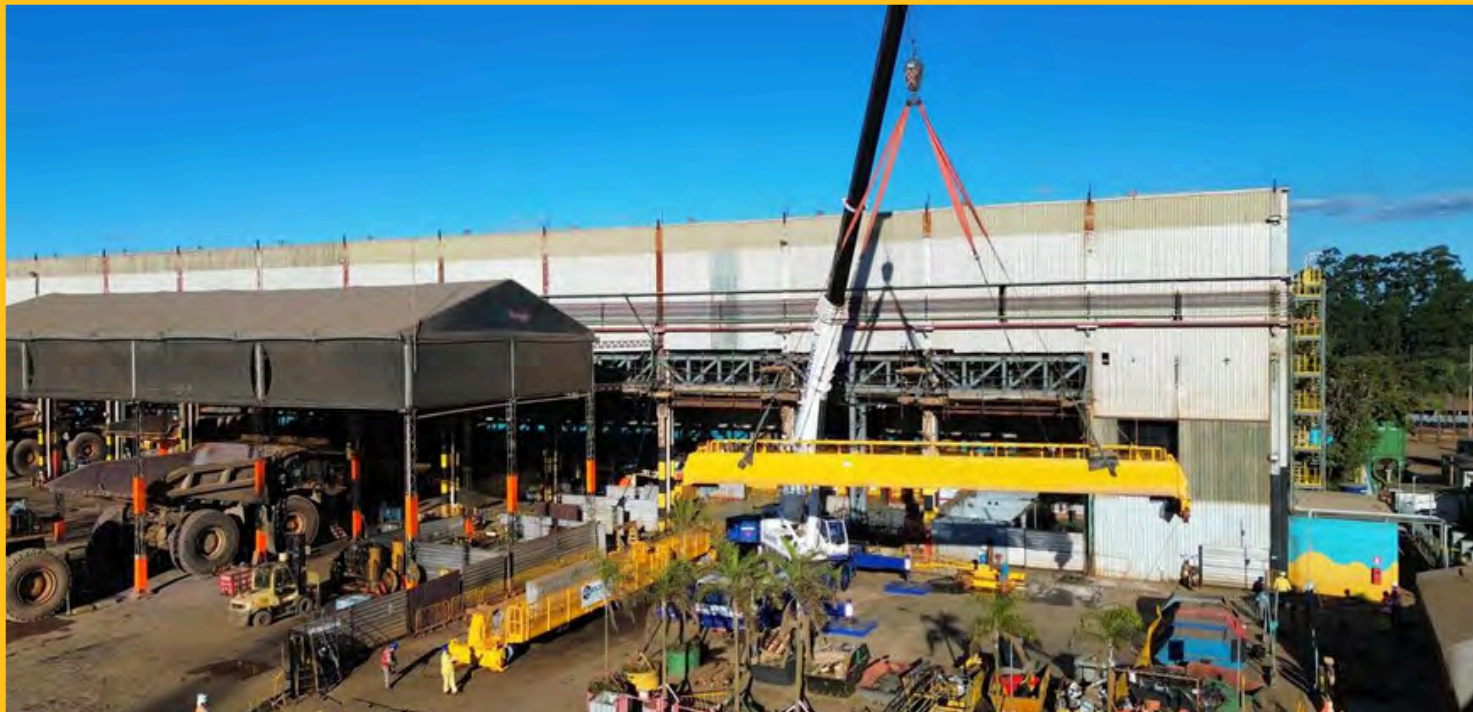
IÇAMENTO DA NOVA PONTE ROLANTE PARA MONTAGEM NA OFICINA DE MANUTENÇÃO - VALE CAUÊ ITABIRA/MG
