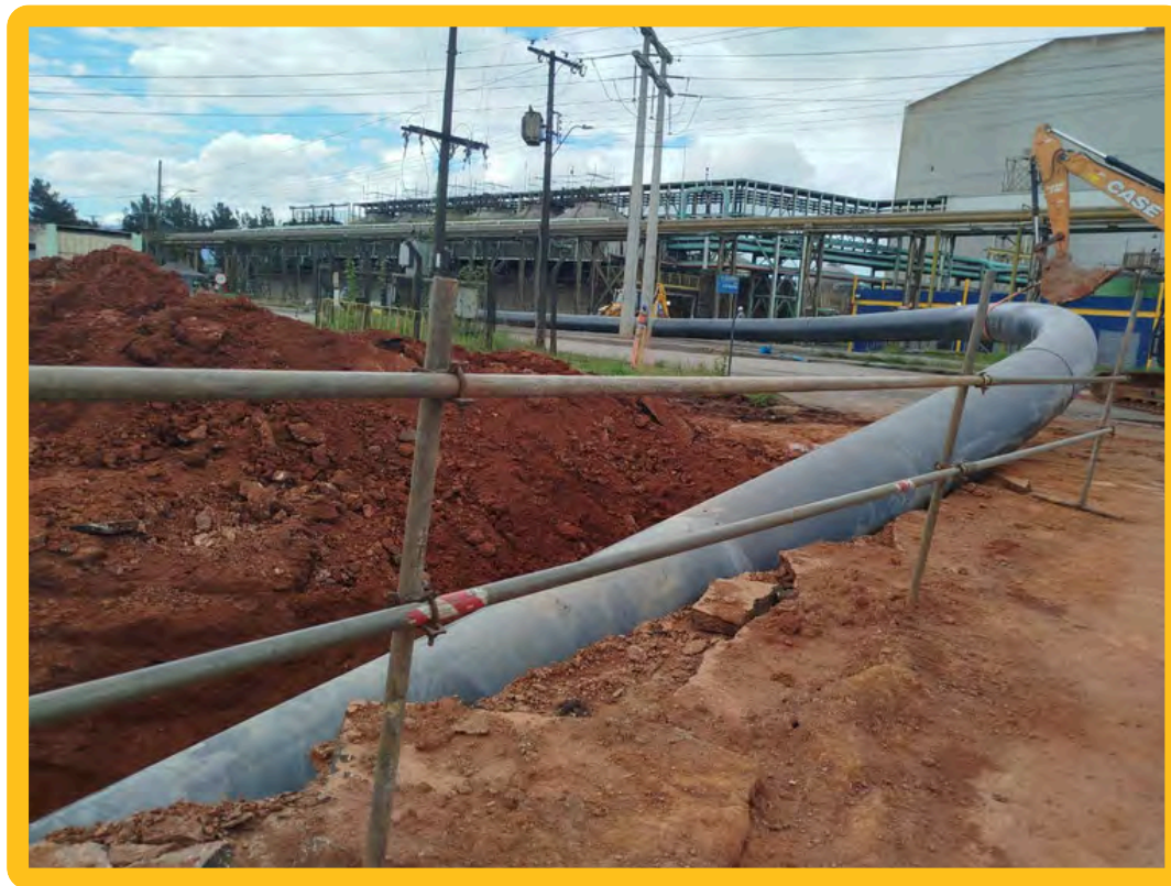
INSTALAÇÃO DE PEAD PARA DRENAGEM DA REDE PLUVIAL NA ACIARIA - OURO BRANCO/MG
