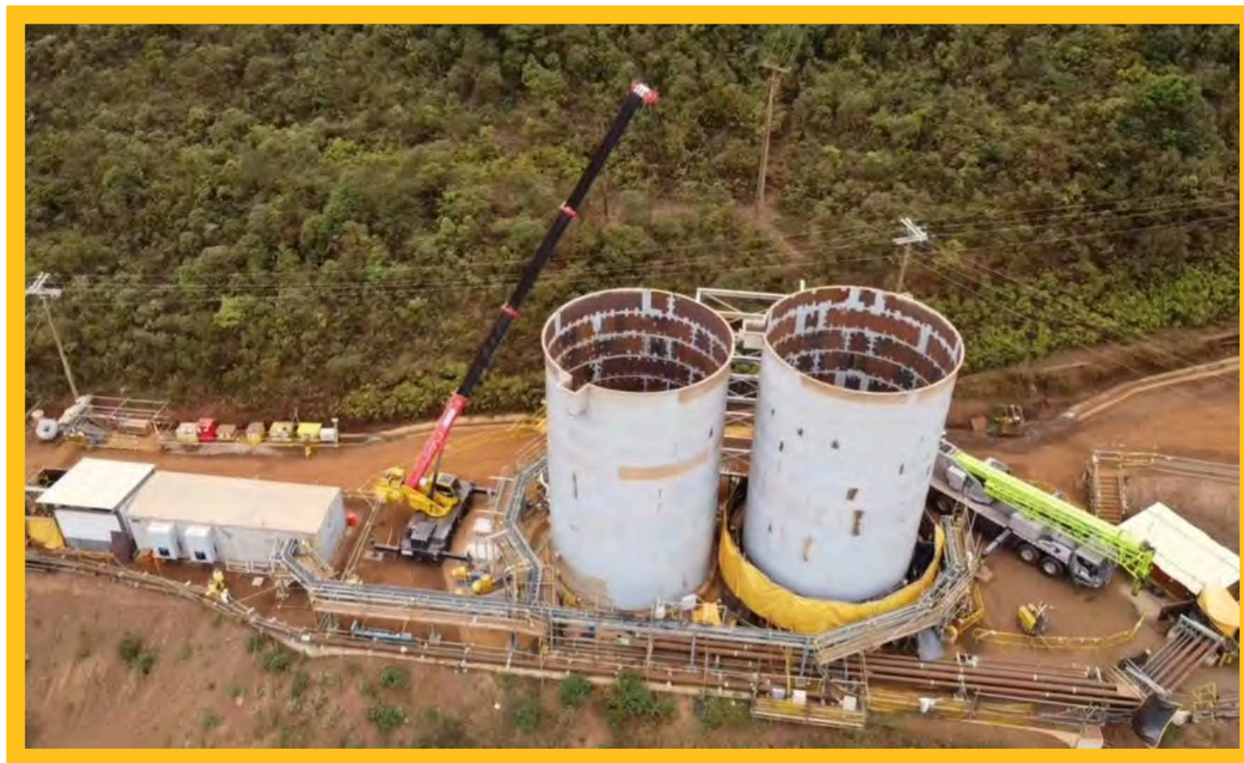
OBRA CIVIL E MONTAGEM ELETROMECAÂNICA DE RELOCAÇÃO DAS INTERFERÊNCIAS ITM-A - MINA DO PICO - ITABIRITO/MG
