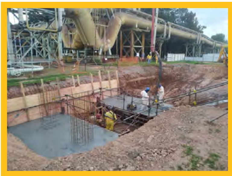
BASES CIVIS DE SUPORTES DE TUBULAÇÃO DE COG E GAF - GERDAU - OURO BRANCO - MG
