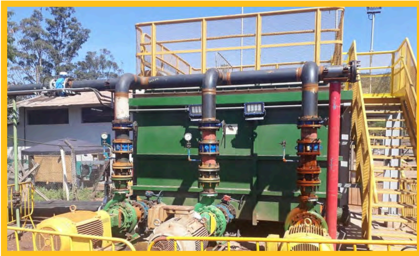
MONTAGEM DO TANQUE E TUBULAÇÃO DE BOMBEAMENTO DO BAIRRO PENHA - ITABIRA/MG
