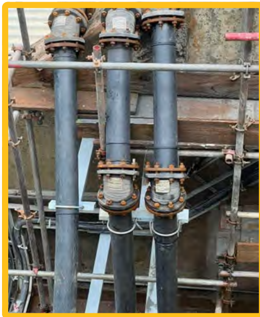
SUPORTAÇÃO DAS LINHAS DE RECALQUE DAS BOMBAS, MONTAGEM DA PLATAFORMA DO TQ-091, MONTAGEM DAS LINHAS DOS DRENOS DA CALHA DO MATEC E ADEQUAÇÃO DA LINHA DE RECALQUE DAS BOMBAS
