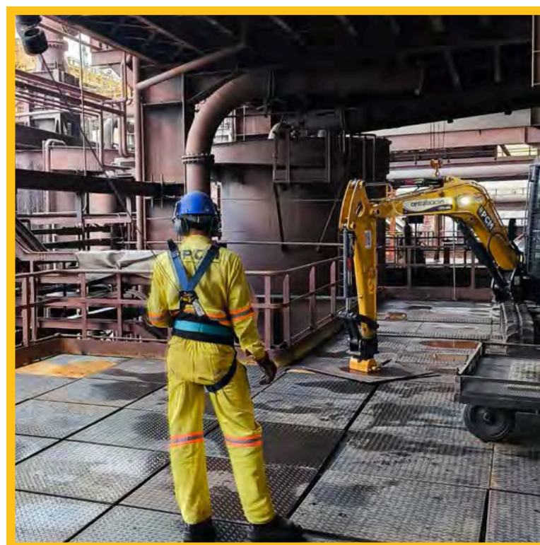
TROCA DE CHAPAS DE AÇO NO PISO DO PRÉDIO DA MOAGEM - MINA DE CONCEIÇÃO/MG
