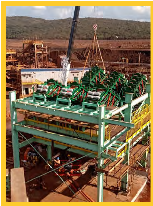
PENEIRAMENTO DE ALTA FREQUÊNCIA E PRÉDIO DO SEPARADORES MAGNÉTICOS - ITATIAIUÇU - MG
