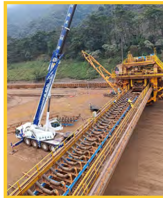
DESMONTAGEM DE ELETROCENTRO E TROCA DE LONGARINAS DA RETOMADORA EM TIMBOPEBA/MG
