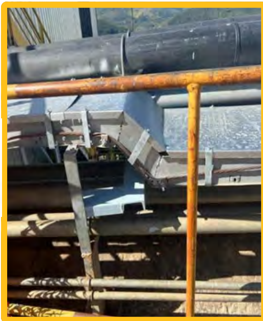
MONTAGEM DAS TRAVAS DAS TAMPAS DOS LEITOS DE 400MM, REVESTIMENTO DO TANQUE TQ-091 E ADEQUAÇÃO DE ESCADA DE ACESSO A BASE DO TQ-091
