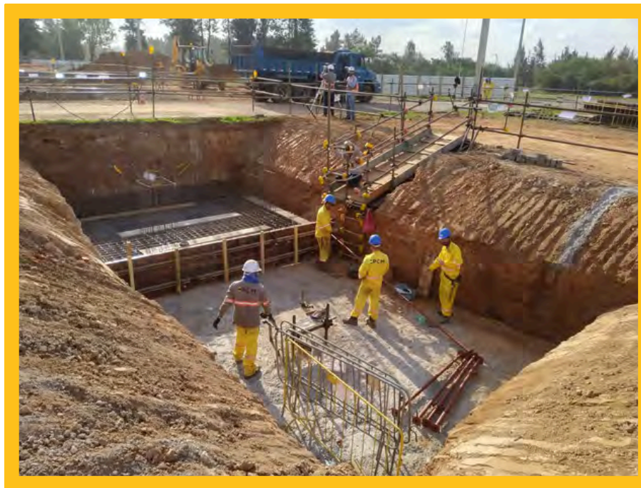
BASES CIVIS DE SUPORTES DE TUBULAÇÃO DE COG E GAF - GERDAU - OURO BRANCO - MG
