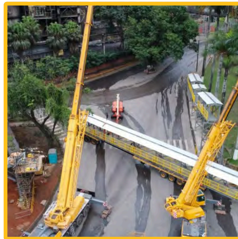
FABRICAÇÃO E MONTAGEM DE PASSARELA DE ACESSO - USINA MONLEVADE / MG
