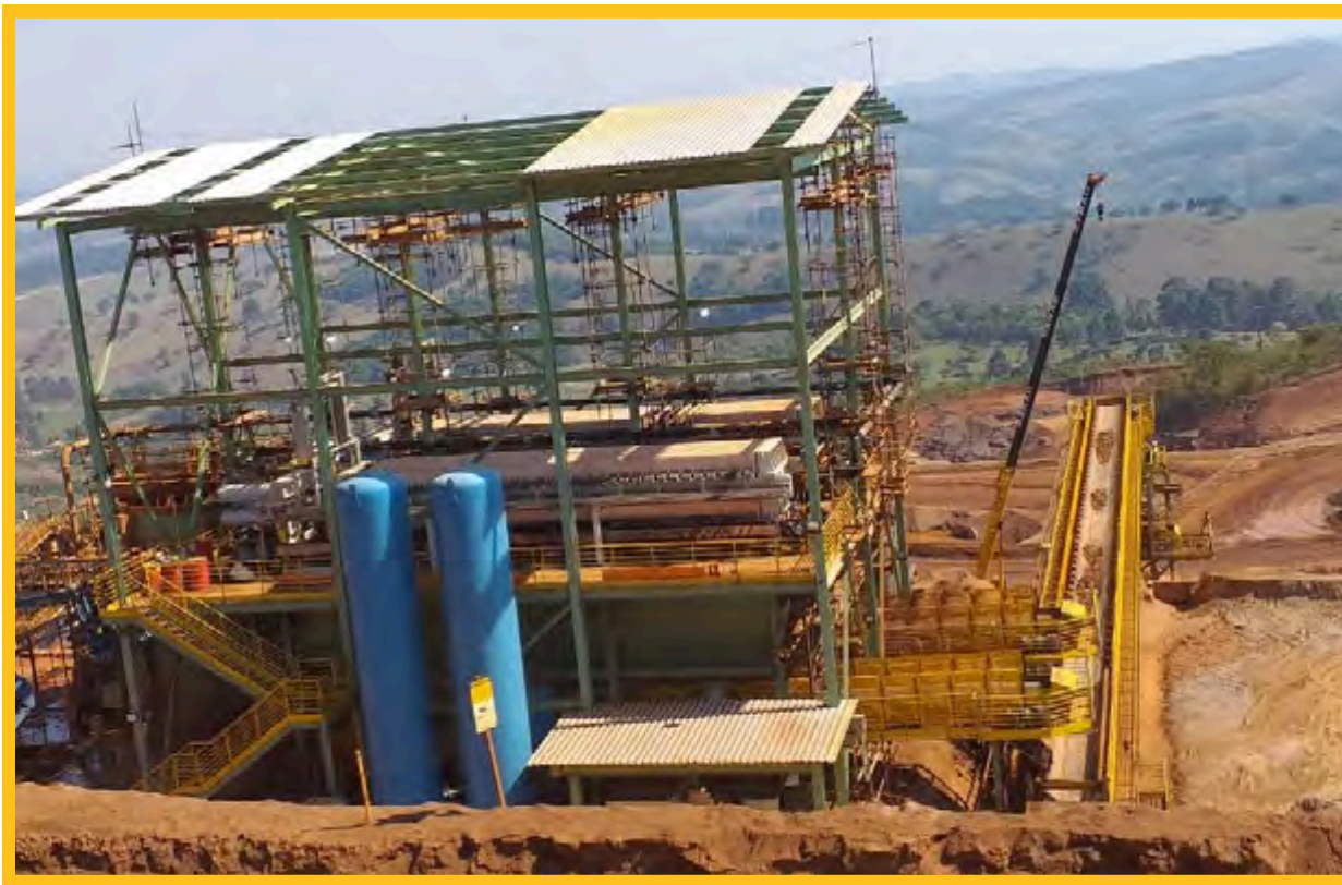
PRÉDIO DO SISTEMA DE FILTRAGEM DE REJEITO - JMN - DESTERRO DE ENTRE RIOS - MG
